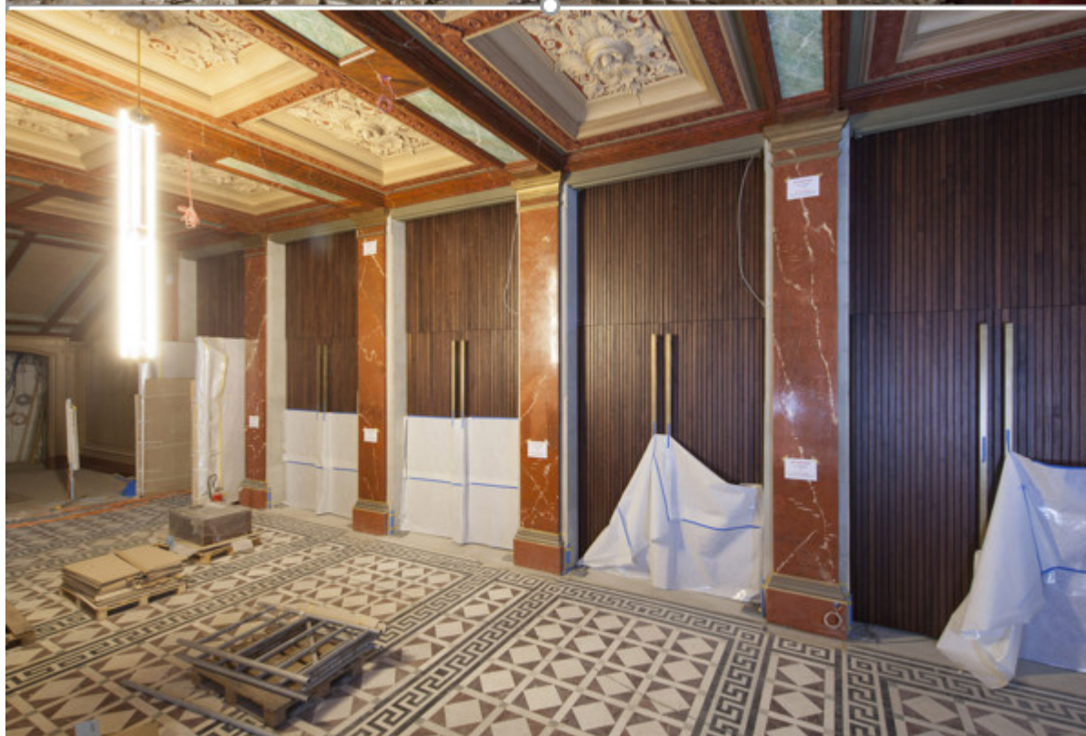
Фойе на первом этаже до и после ремонта (© GTG)
