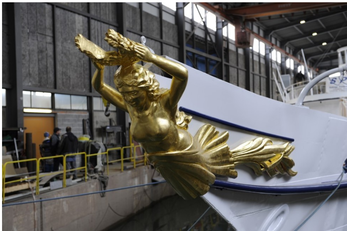
Ремонтные работы на пароходе «Suisse» ( abvl.ch )
