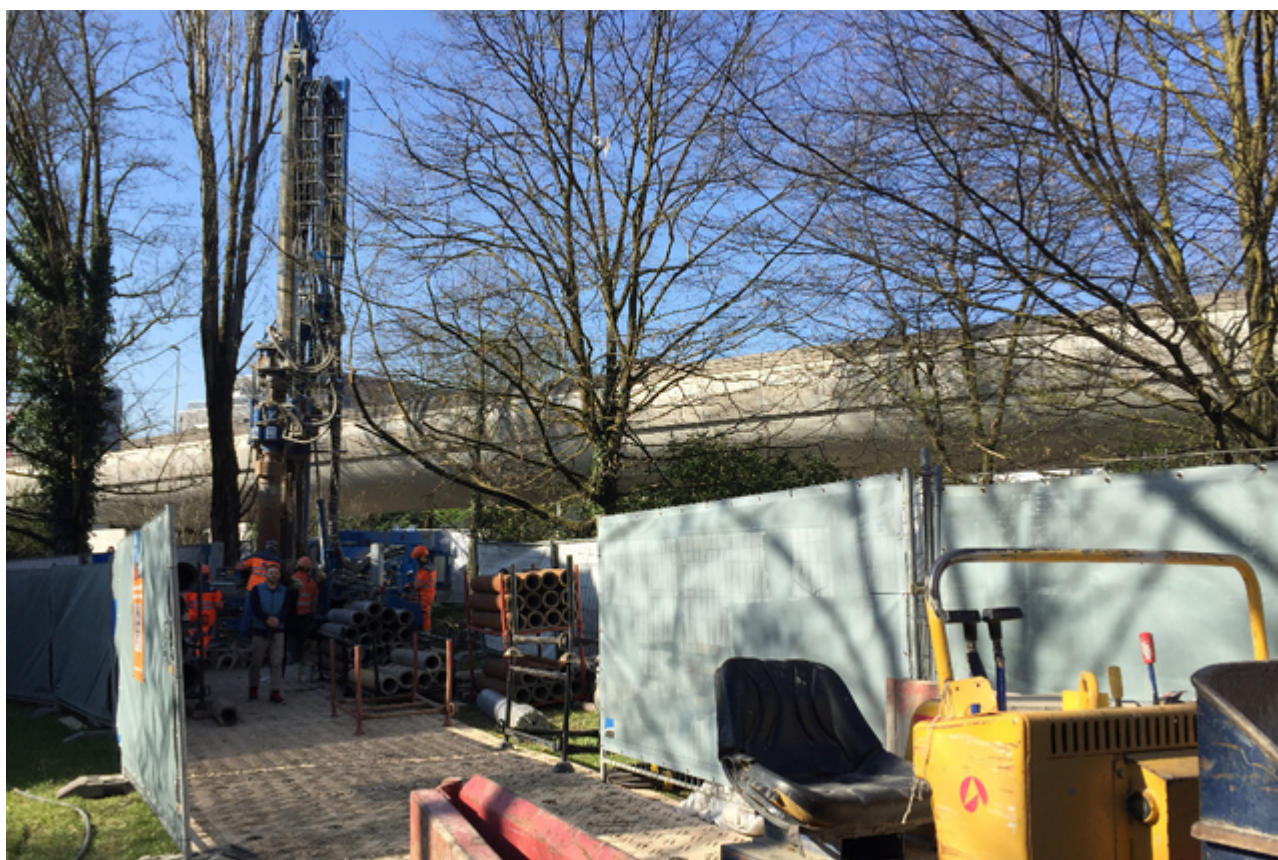
Начало работ в Вернье (© Antoine Grosjean/TdG)
