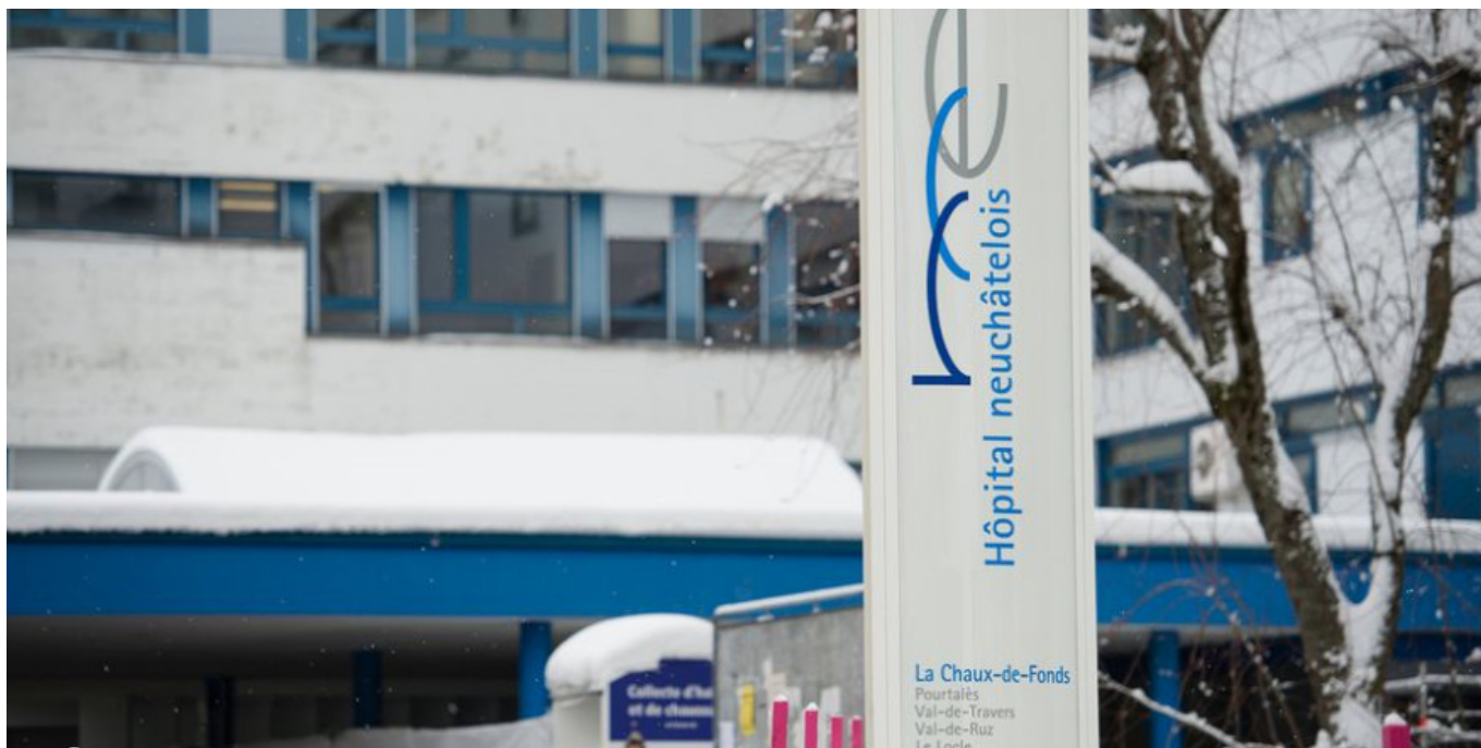
Кантональный госпиталь Невшателя в Ла Шо-де-Фоне
