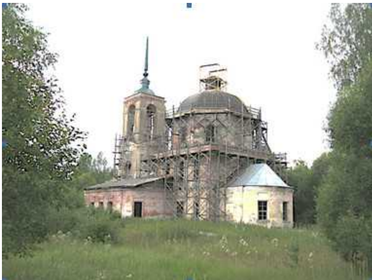
Никольская церковь в строительных лесах (©Marion Garcia)
