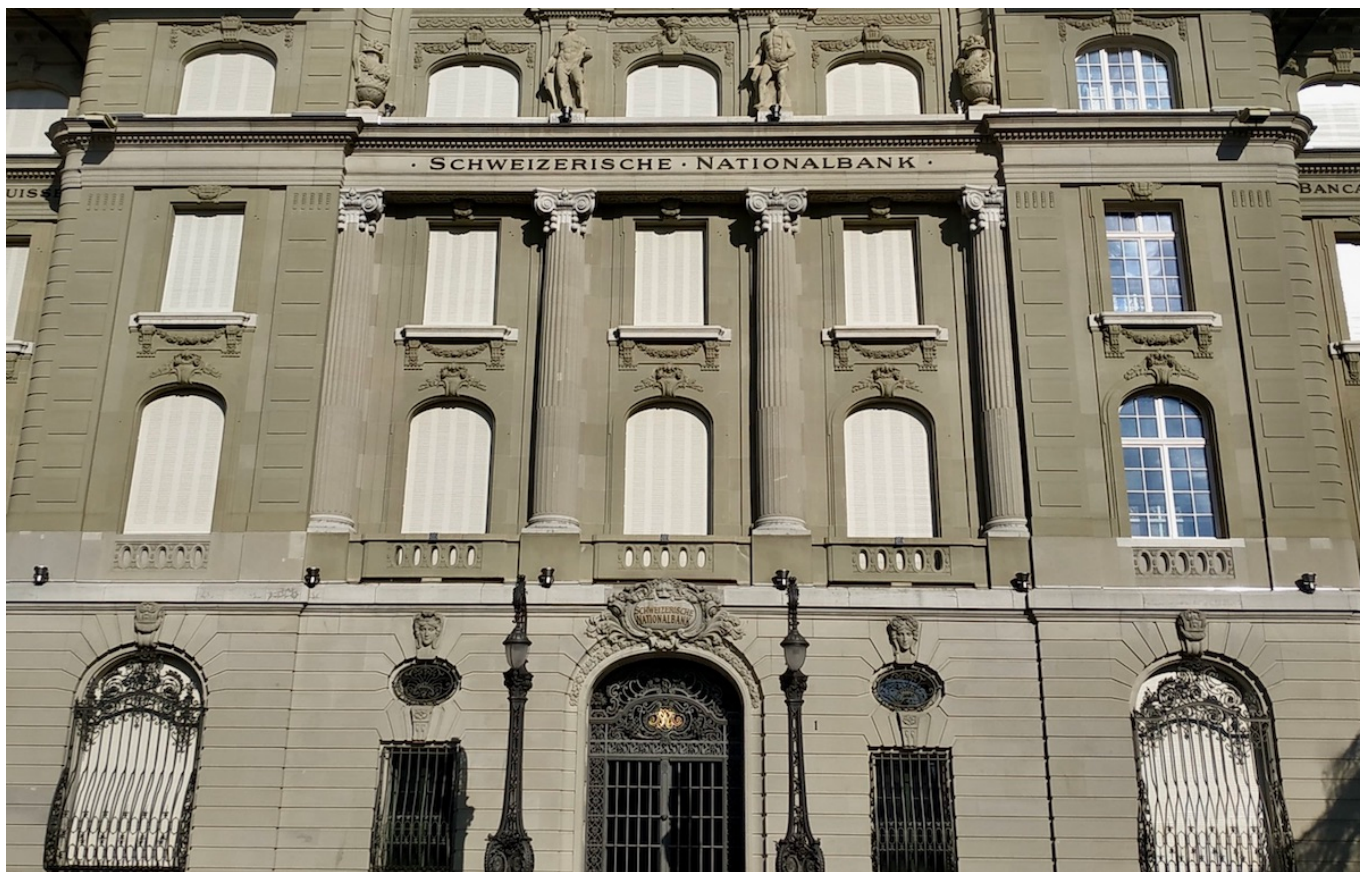
Здание Нацбанка в Берне. Фото: Nashagazeta.ch
