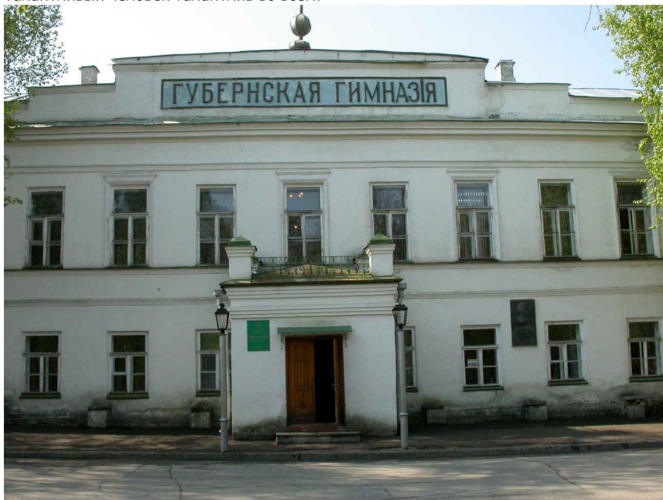
Главный корпус гимназии.
