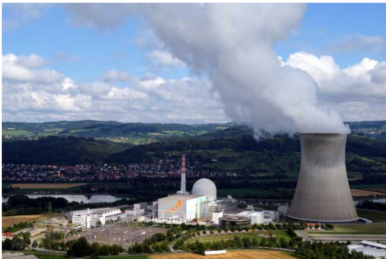
АЭС в Лайбштадте, Швейцария ©ensi.ch
