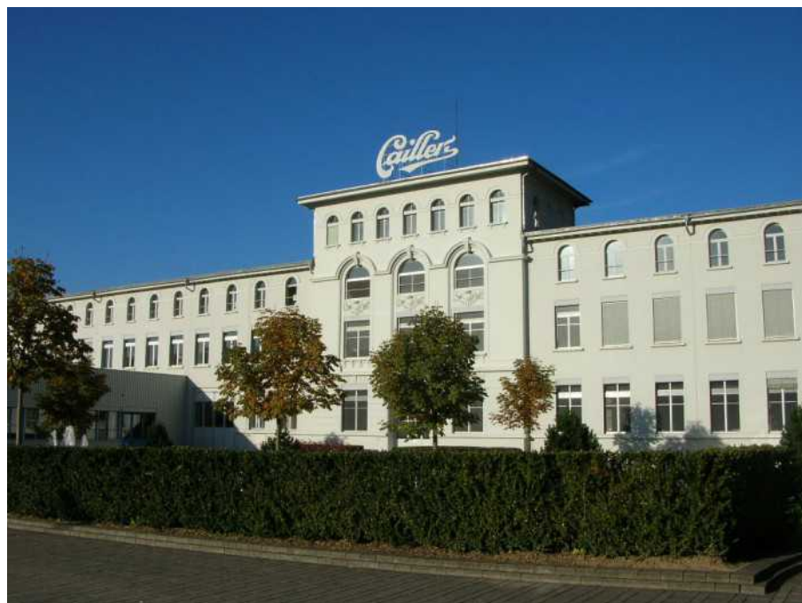
Здание шоколадной фабрики Cailler в Брое
