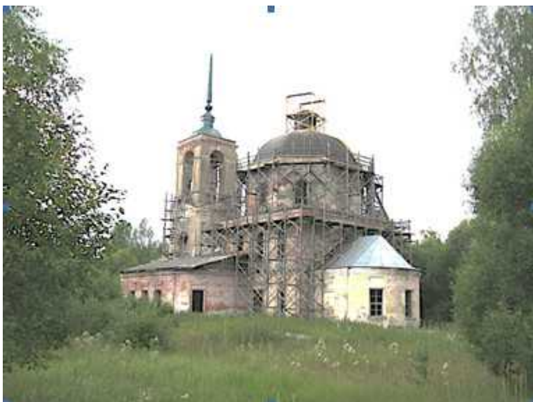
Никольская церковь в строительных лесах (©Marion Garcia)
