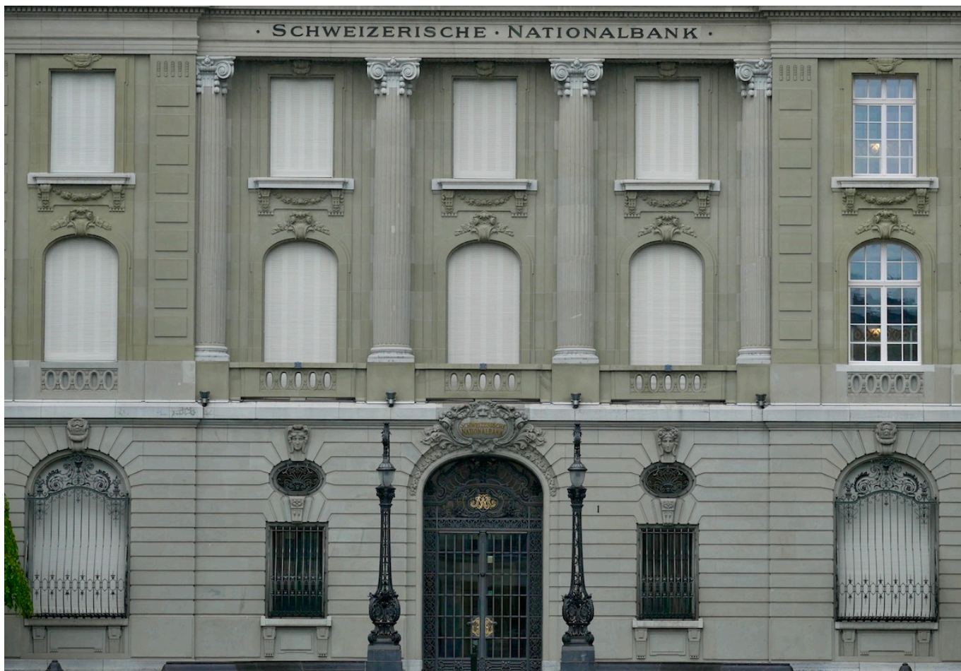
Здание Нацбанка в Берне. Фото: Nashagazeta.ch
