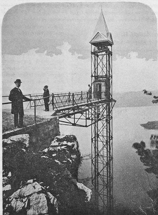
Abb. 3. Obere Plattform und Zugangsteg.
