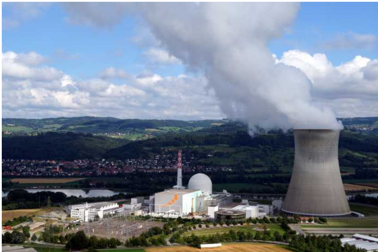
АЭС в Лайбштадте, Швейцария ©ensi.ch
